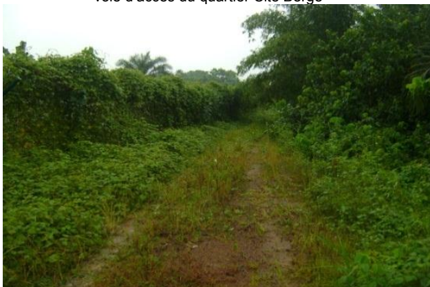
Route envahie par la végétation
