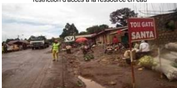
Photo 4 : Péage de Santa : encombrement des emprises
