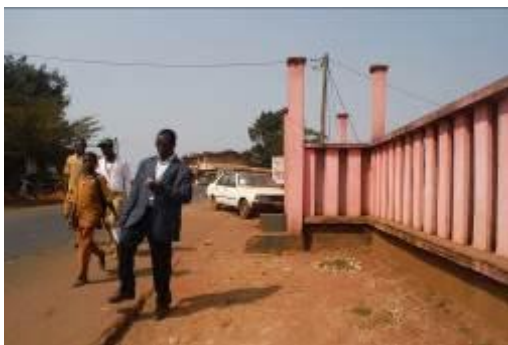
Photo 1 : Pk 1+800 barrière du Centre social de Babadjou dans l'emprise
