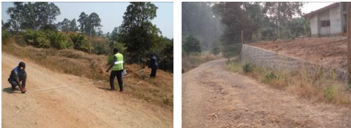
Photo 5 : mesure de l'emprise à Ntaanché après le virage
